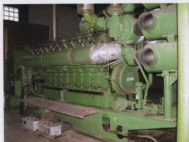
Motor de gas combinado con alternador (cogeneración).
